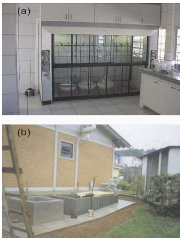
Figura 16- LCR (a) Sistema de Destilação e (b) Caixas de tratamento de água. Fonte: ALBERGUINI et al. , (2003, p. 293)
