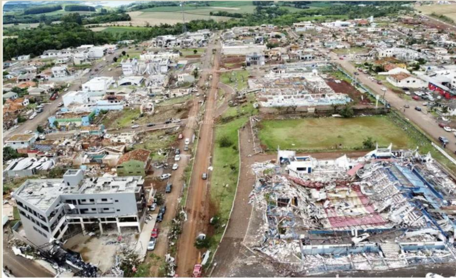
Rio Bonito do Iguazu ficou 90% destruída após passagem de tornado — Foto: Jefferson Silva/ Rádio Campo Aberto/ Coprossel
